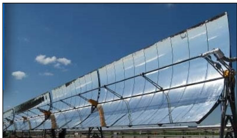
Figura 17 – Un sistema solare a collettori parabolici. Questi sistemi, a differenza dei moduli fotovoltaici piani, focalizzano la luce riflessa con il rischio di arrecare danni permanenti alla retina (zona rossa del Diagramma). Fonte immagine http://www.solaritaly.enea.it/
